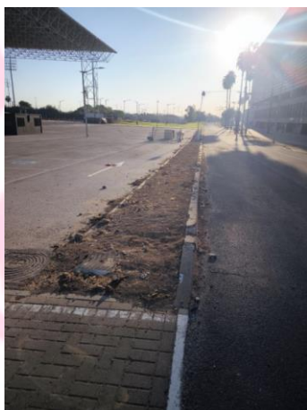
Imagen 13: Estado actual parterre con bordillo a eliminar.
