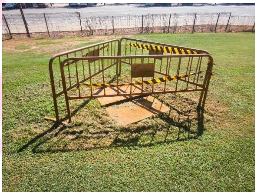
Imagen 4: Arqueta con tapa provisional
